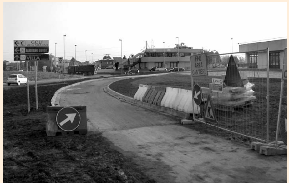
Lavori in corso per la nuova pista ciclopedonale presso la Tangenziale di Colnago
